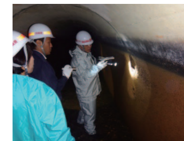
(写真)東系列導水路トンネル内部調査状況
