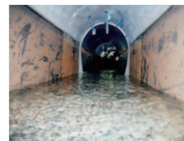
(写真)東系列導水路トンネル内部
