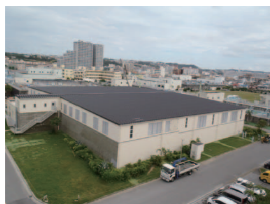
(写真)沈でん池改良後
