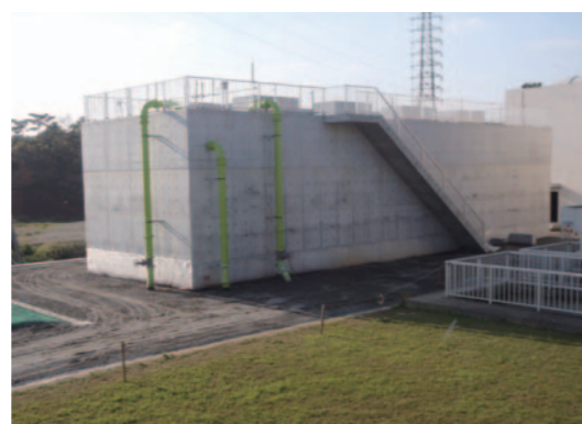
(写真)活性炭施設の整備(新設)
