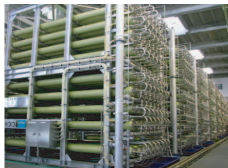
(写真) 海水淡水化センターの心臓部に当たる逆浸透設備
