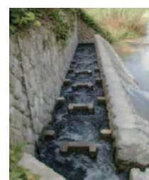
(写真) 河川魚道
