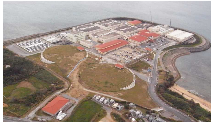
石川浄水場（平成 25 年 12 現在）
