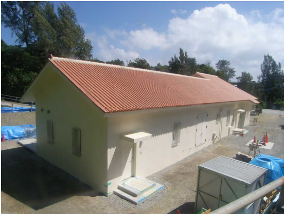
億首取水ポンプ場
