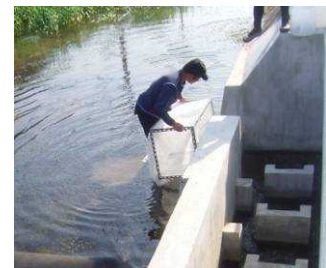
取水河川魚道 モニタリング調査
