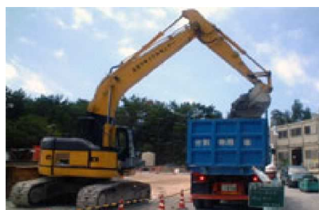
建設副産物の再利用
