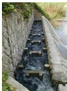
取水河川魚道
