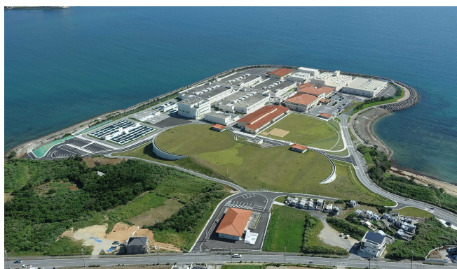
石川浄水場全景
