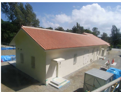
金武ダム取水ポンプ場
