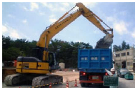
建設副産物の再利用
