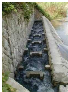
取水河川魚道
