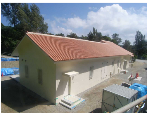
金武ダム取水ポンプ場
