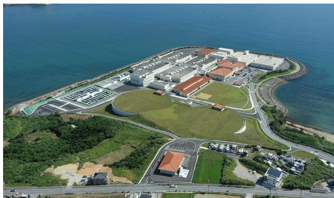
石川浄水場全景
