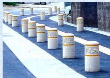
生成ペレットを活用した車止め
