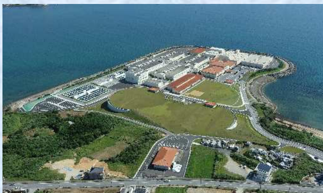
石川浄水場全景
