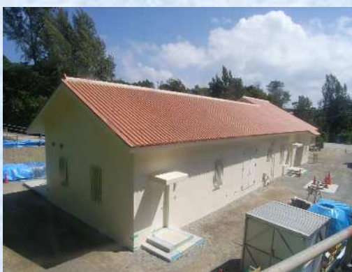
金武ダム取水ポンプ場
