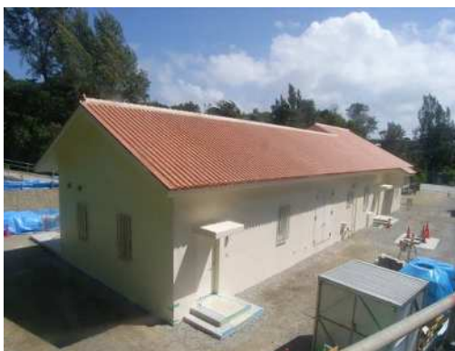
金武ダム取水ポンプ場
