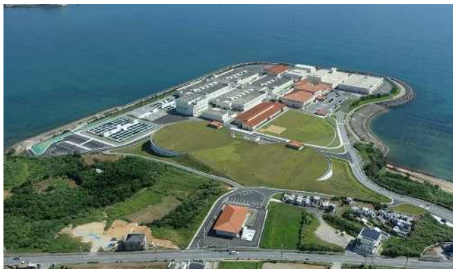
石川浄水場全景
