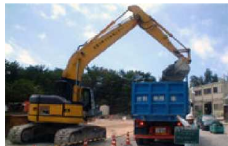
建設副産物の再利用
