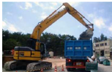
建設副産物の再利用
