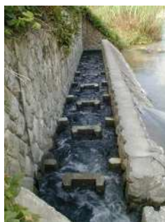
取水河川魚道
