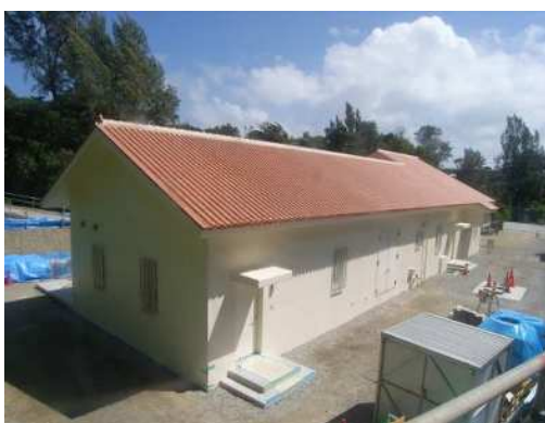
金武ダム取水ポンプ場
