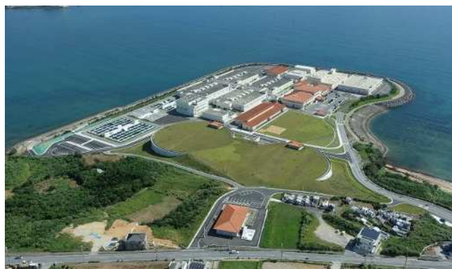
石川浄水場全景
