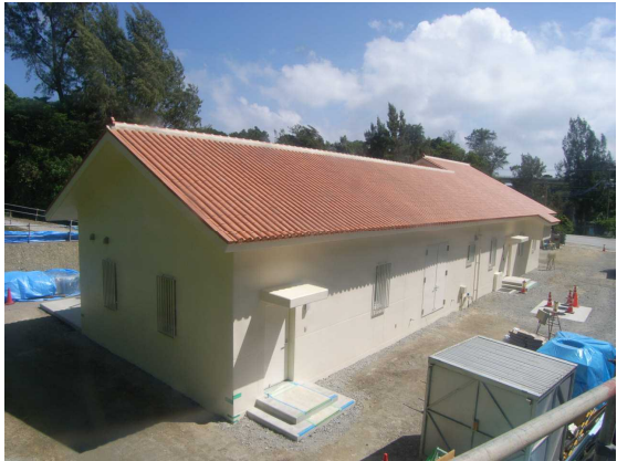
金武取水ポンプ場
