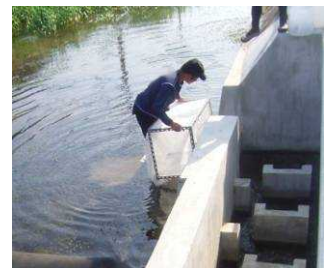
取水河川魚道 モニタリング調査
