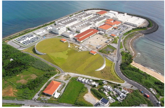
石川浄水場（平成 26 年 9 現在）
