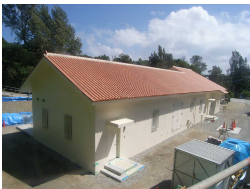
金武ダム取水ポンプ場
