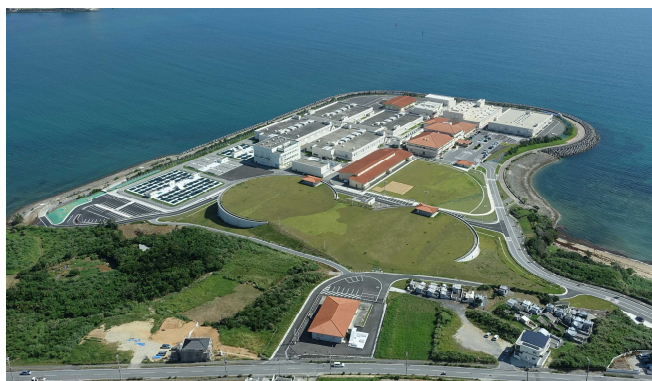
石川浄水場全景
