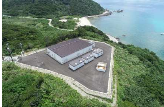
離島海水淡水化施設（座間味村阿嘉島）
