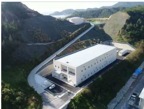
伊平屋浄水場(伊平屋村)
