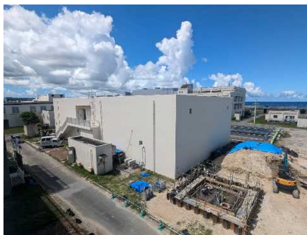
北谷浄水場薬品注入棟建築工事
