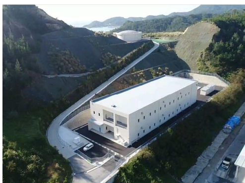
伊平屋浄水場(伊平屋村)
