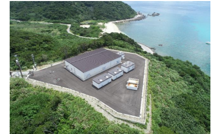
離島海水淡水化施設(座間味村阿嘉島)
