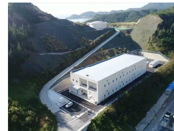
伊平屋浄水場(伊平屋村)
