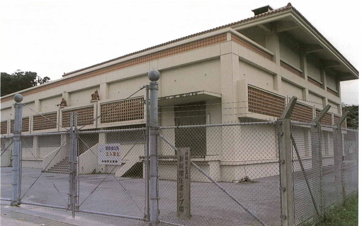
新垣増圧ポンプ
