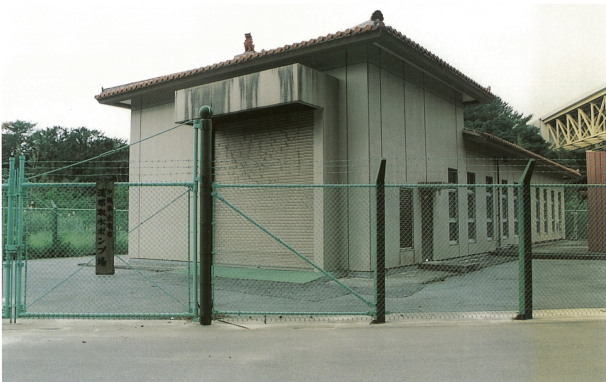
漢那取水ポンプ場
