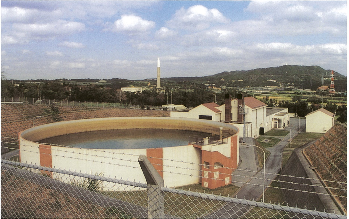
伊波増圧ポンプ場
