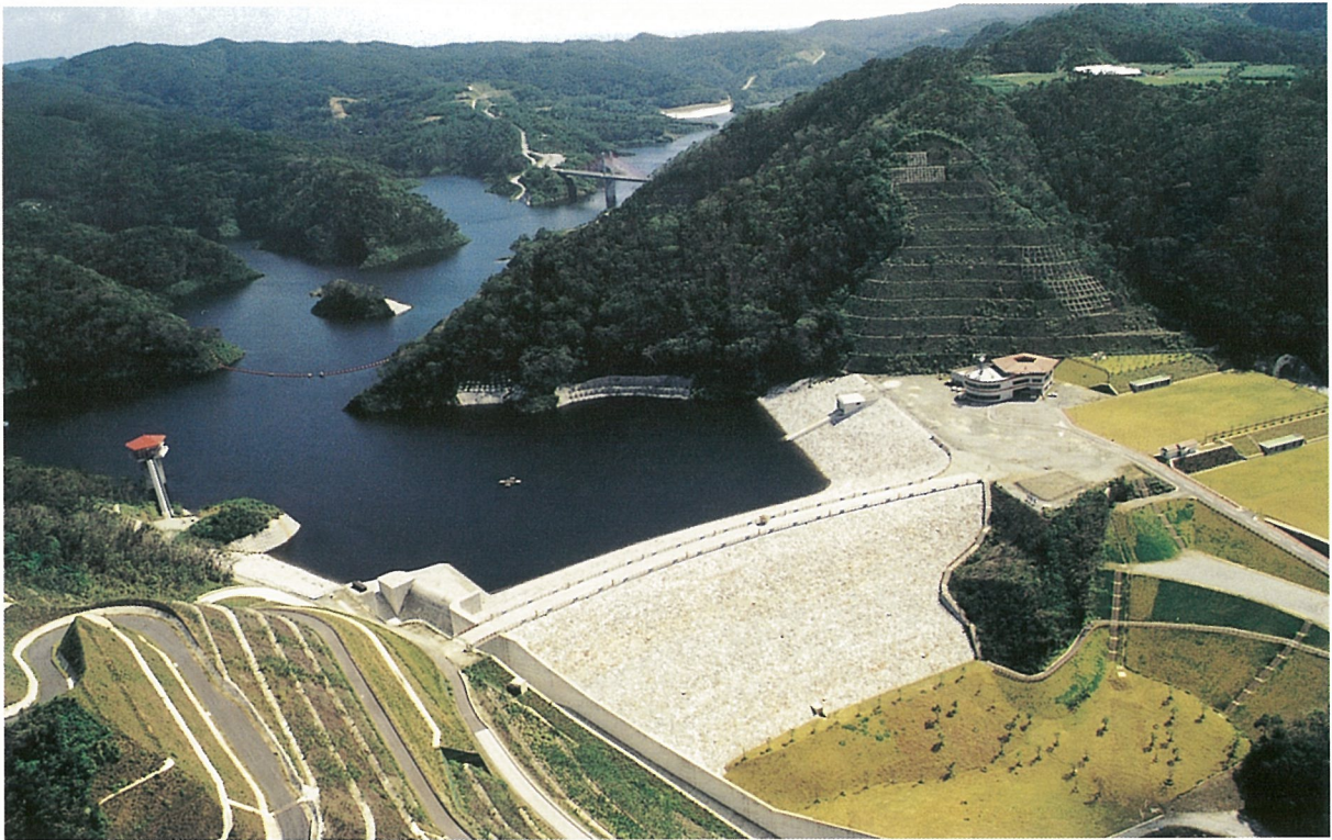
羽地ダム（試験湛水中）
