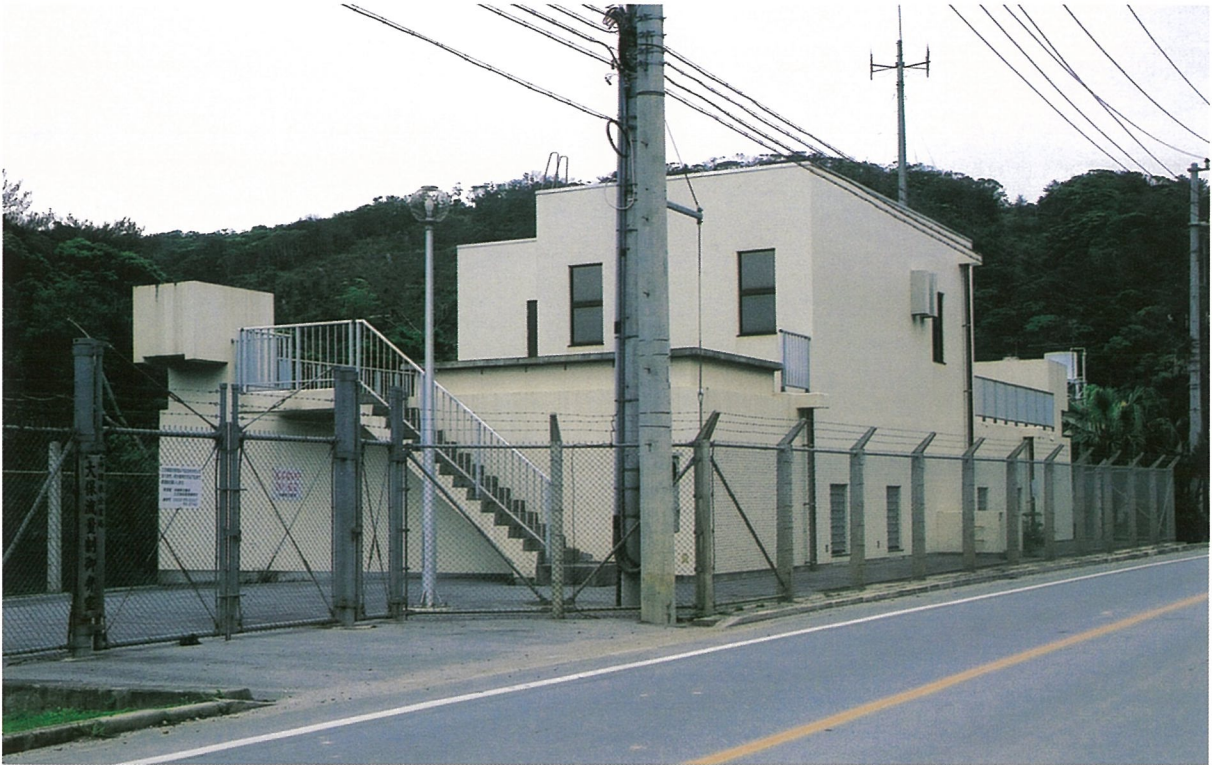
大保流量制御弁室
