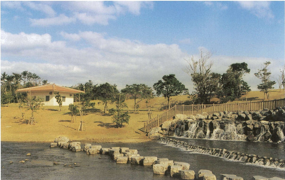
倉敷ダム注水施設
