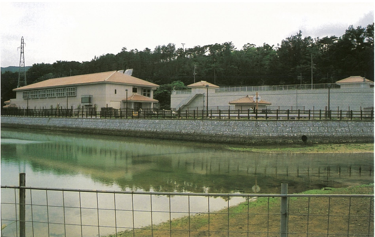
許田増圧ポンプ場
