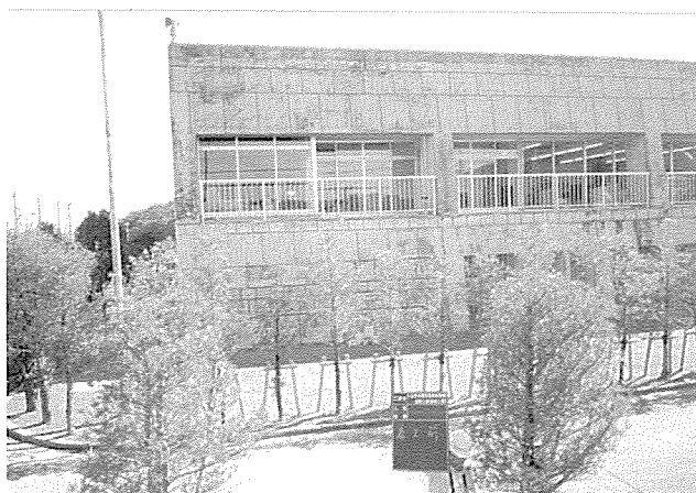
久志浄水場管理本館 耐震改修前
