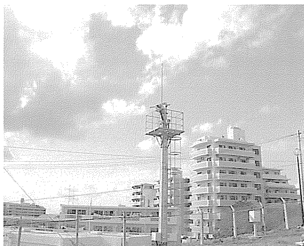
各施設の監視カメラ
