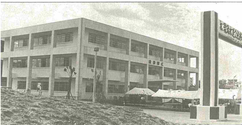
琉球水道公社新社屋全景。
