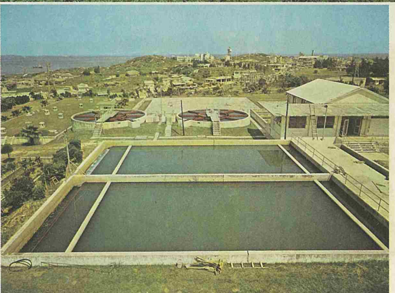
一日の浄化能力一万一千四百キロリットル、那覇市の飲料水の大供給源となっている泊浄水場
