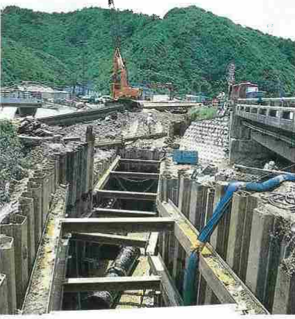
▲導水管の工事
