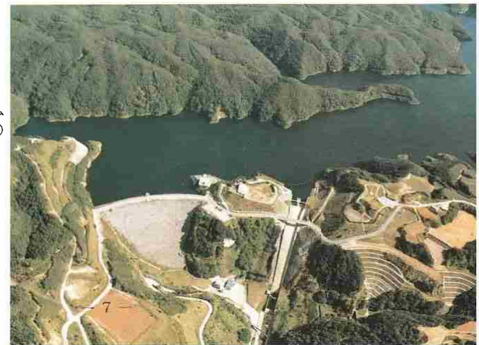
昭和49年12月に完成した福地ダム (沖縄県民の水ガメとなっている)
