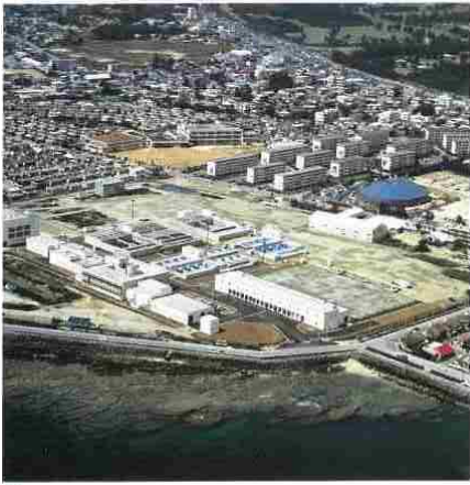
▲一部の供用を開始した北谷浄水場。1日21万5千㎡の浄水能力をもつ県下最大の浄水場になります。
