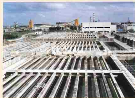
▲薬品沈でん池
