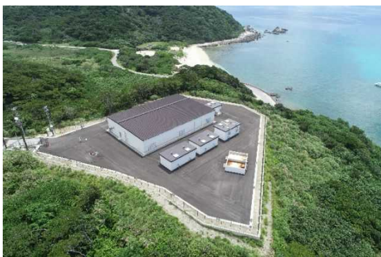
離島浄水場の全景(座間味村阿嘉島)
